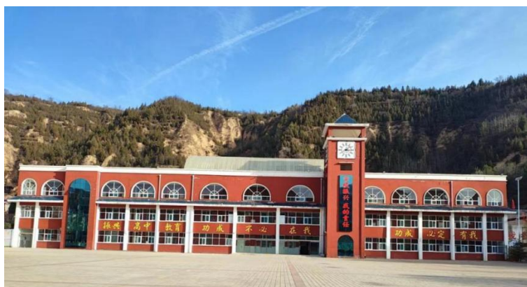
图 1-1 永和县职业中学教学楼（办公室）
